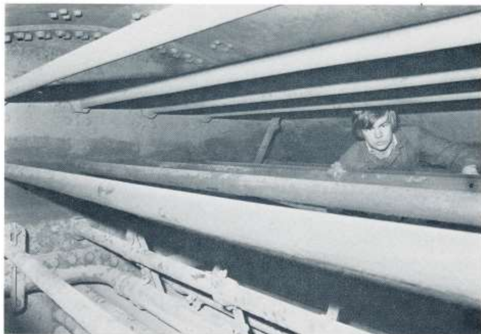
Per-Uno Karlsson poserar inne i pannans ovan del. Närmast över och under sig har han en del stagbultar. Längst ner till vänster skymtar ett tubpaket. Genom tuberna går - när pannan är i drift - de heta rökgaserna som värmer vattenet så att ånga bildas. Foto Ake Karlsson 6 december 1982.
