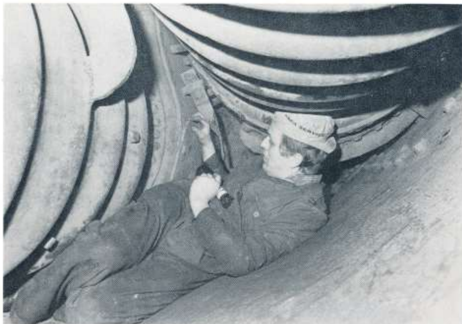
Ake Karlsson har här krupit in på vattensidan av pannans botten (pannan är tömd på vatten). På bilden syns en del av de korrugerade eldrören samt en bit av flammugnens undersida. Foto Per-Uno Karlsson 6 december 1982.
